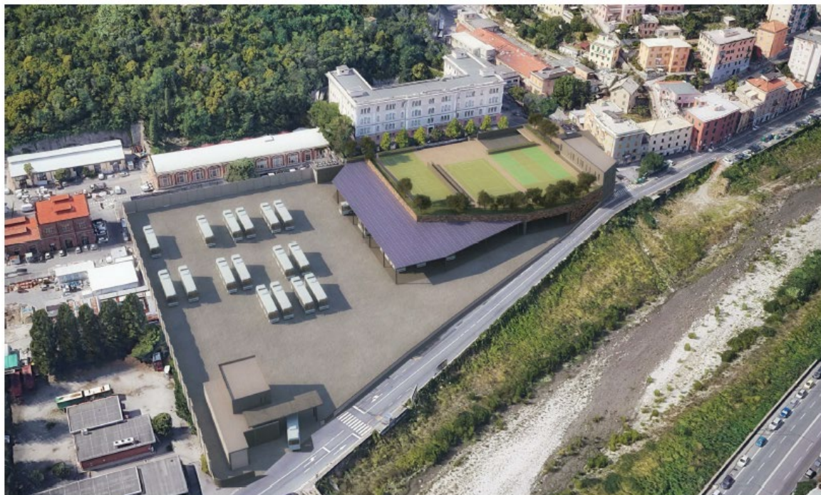
Figura 13: Inserimento della rimessa Gavette in cui è apprezzabile il ruolo di ibridazione della copertura
